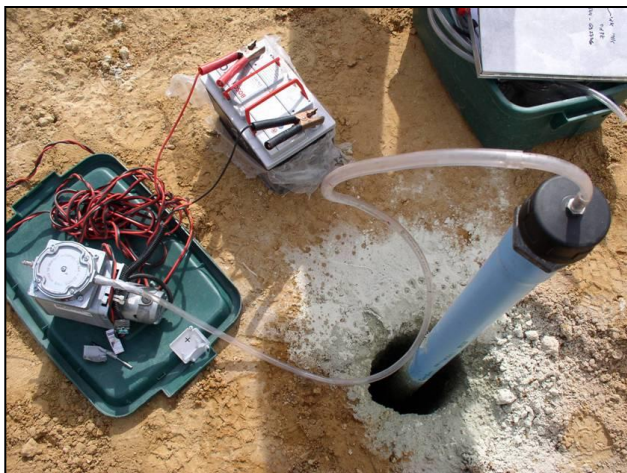
איור 5 - שאיבת גזי קרקע מתוך צינור קידוח המחורץ בתחתיתו.
